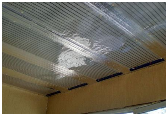
Sumontuoti infraraudonųjų spindulių elementai (prieš apdailą)
